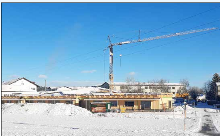
„Stadt der Kinder“ Baustelle im Schnee
