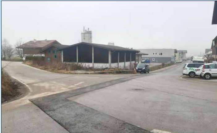
Künetten Wasserleitungsbau Gewerbegebiet Pongau noch vor Wintereinbruch asphaltiert
